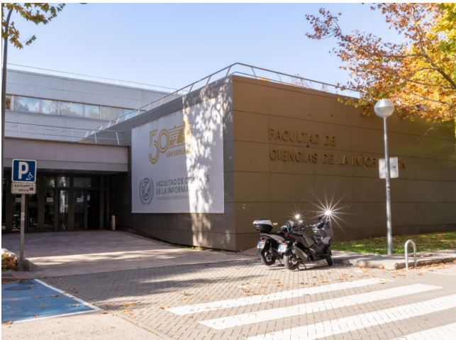
(a) Aulario Pilar Miró.
